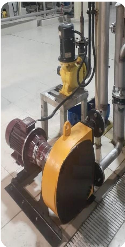
شكل (3) : پمپاز مواد شيميايي قلبياي در كارخانه توليد
