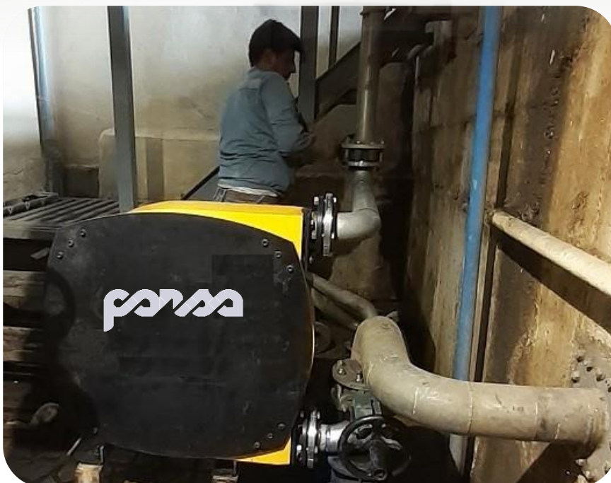
شكل (3) : پمپاز مواد شيميايي قلبياي در كارخانه توليد
